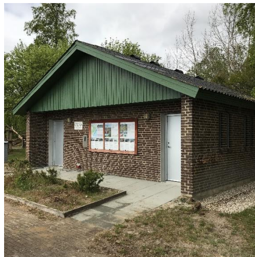
Den renoverede toiletbygning i Trylleskoven.
